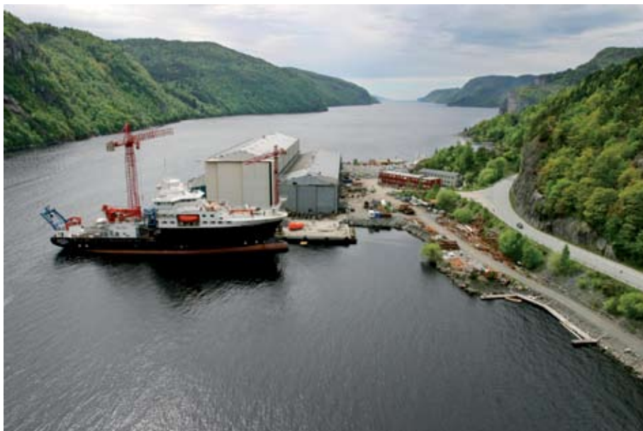
Det blåser friskt på brua 50 meter over Fedafjorden. Utsikten er upåklagelig, her sett sørover mot Kvina verft.
