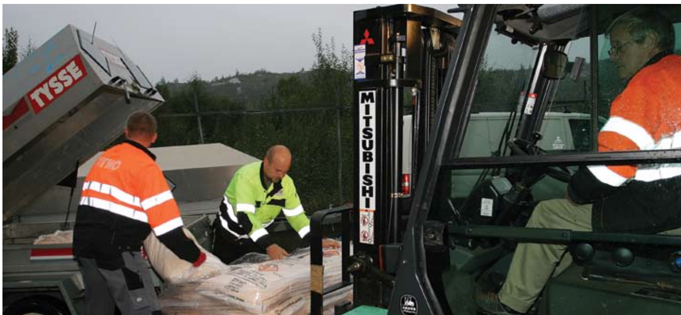
Geir Bergtun fra familiebedriften Bergtun fjell- og betongarbeid trenger sprengstoff og tennere til å skyte ut tomter i et byggefelt i Fjell.
