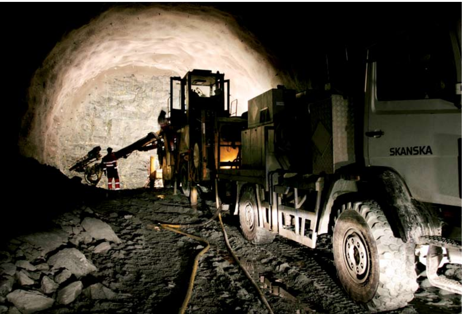
De siste salvehullene er ladet. Det er klart for kobling og sprengning av en ny salve. Hver dag kommer man åtte meter lenger inn i fjellet.
