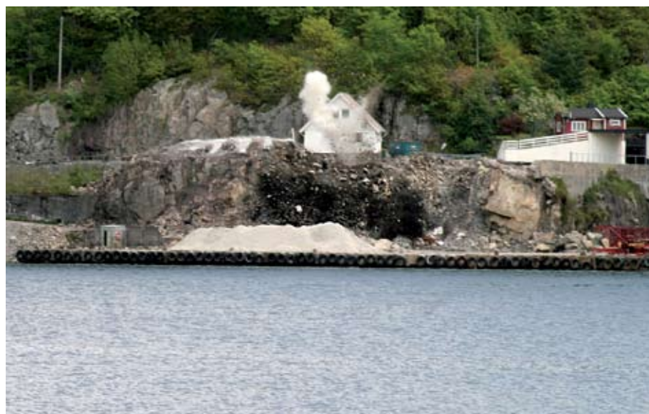
3.000 kubikkmeter fjell rives i filler på østsida av Stolsfjorden. Denne gang ble det knapt krusninger på vannskorpa.
