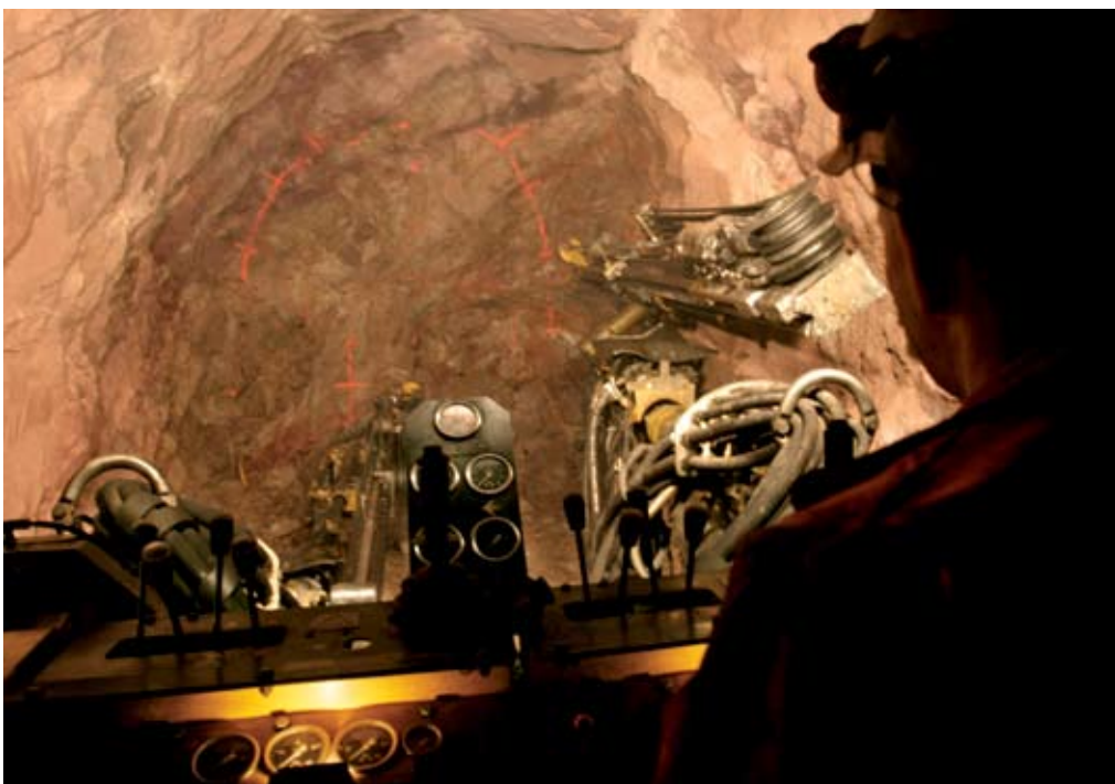
Som et hulemaleri fra steinalderen markerer bormønsteret hvor skytebas Torbjørn Svensson skal bore. Atlas Copcos minste to-boms borerigg, Rocket Boomer 282, er tatt i bruk inne i Hisvatn-tunnelen.
