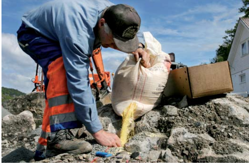
Skytebas Egil Harbo holder et forrykende tempo der han flyr fra hull til hull og mater fjellet med safrangul Anolit. Salvehullene er på opptil 22 meter.
