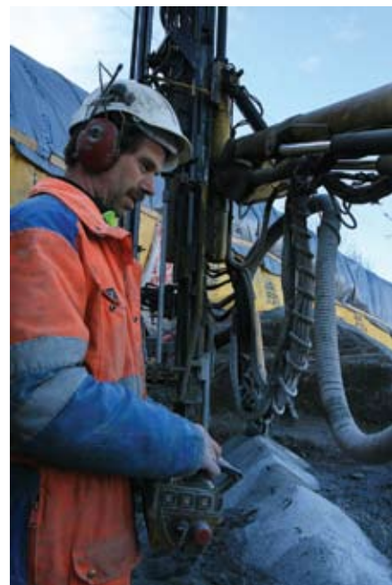
Arne Woldstad fra Hæhre Entreprenør har god kontroll på boreriggen når han punkterer fjellet og gjør klar til siste gjennomslag.
