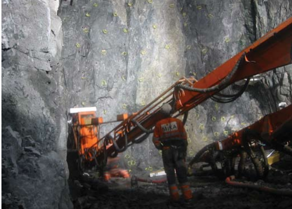
Figur 4 Norsk sprengningsplan i svensk tunnel - Mika AS ved Botniabanan.
