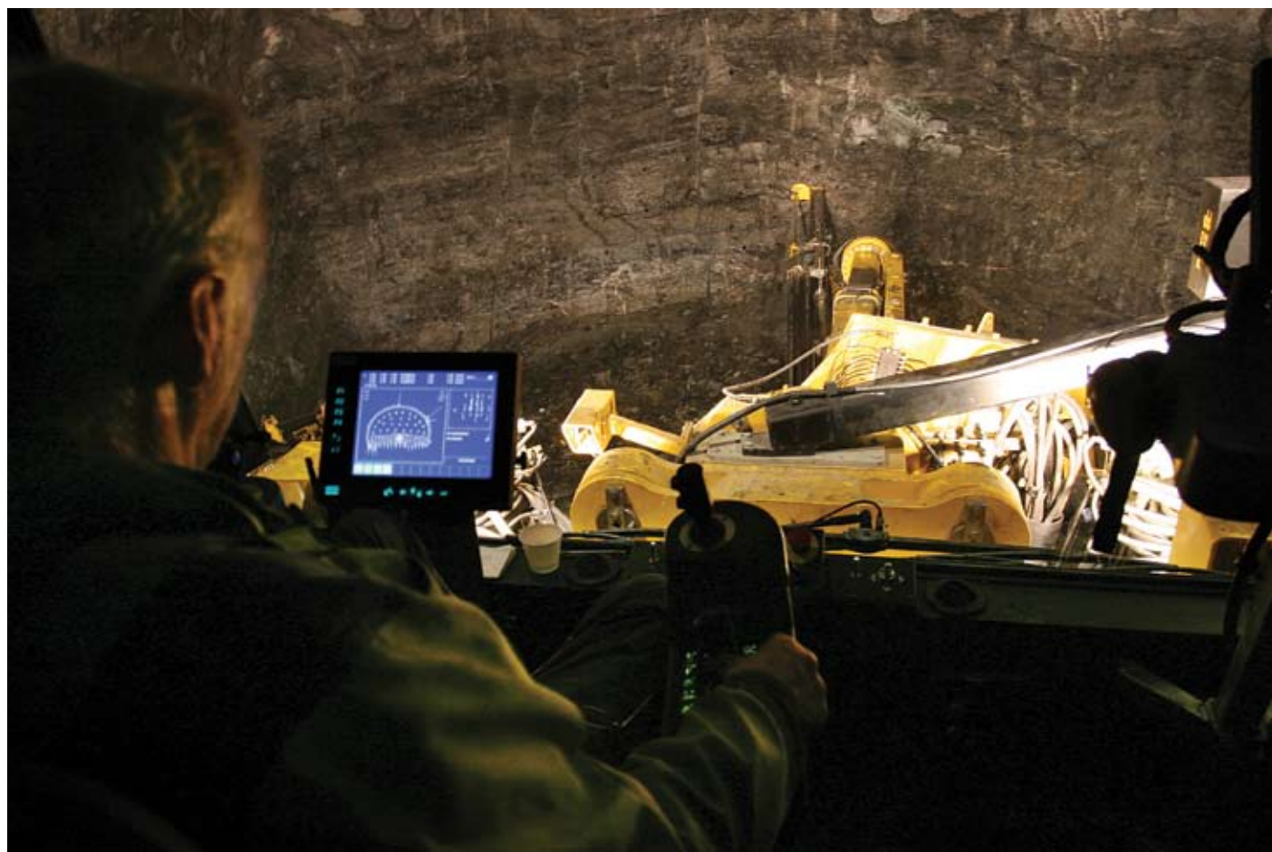
Det tillates ikke mye slinger i valsen, hvis de to endene av Finnfast-tunnelen skal møtes under Boknafjorden om et år.
