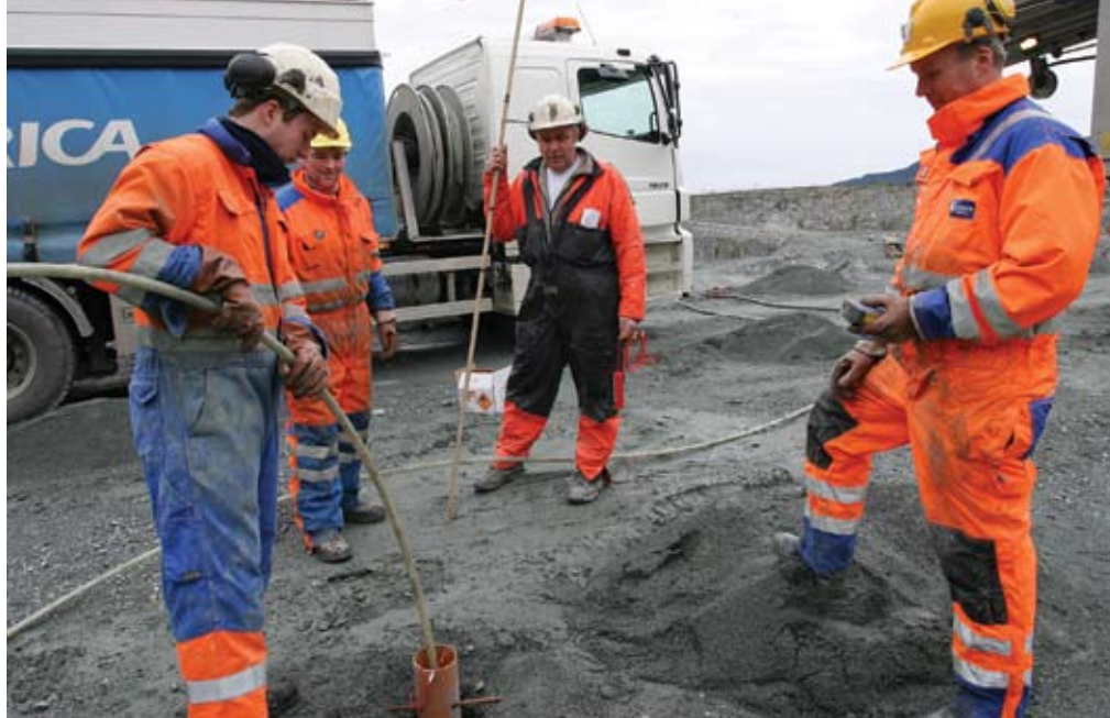
Orica har opprettet en egen stasjon på Norsk Stein som forsyner pukkverket med slurry. F.v.: Thomas Nerli, Morten Søråas, Kjell Petter Hamre og Ivar Marvik.
