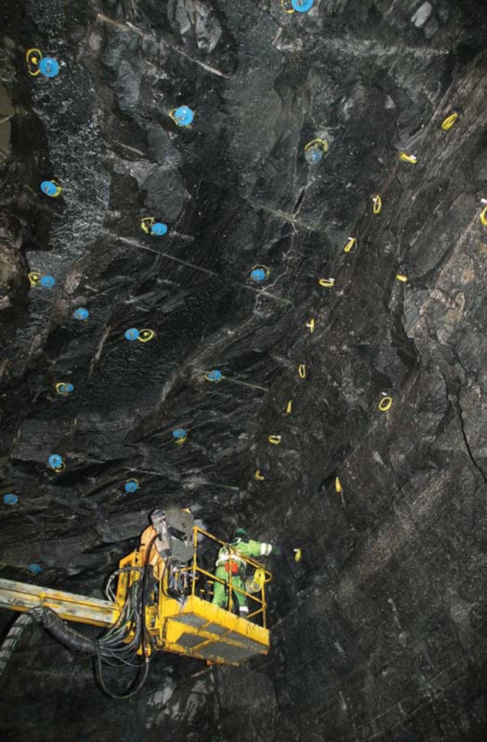
Karl Olav Aakre lader i høyden. 750 kilo slurry går med i hver salve.
