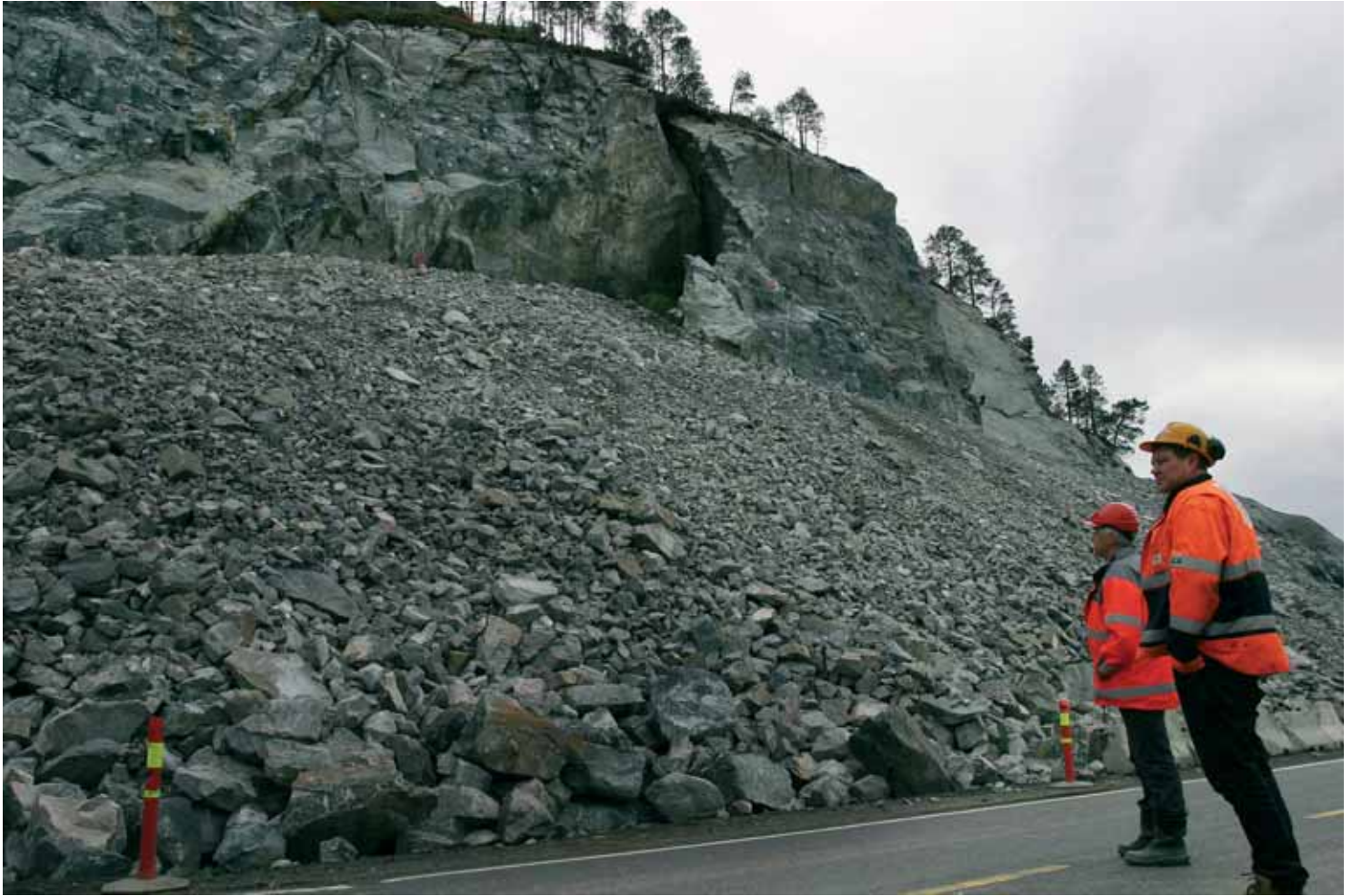
Som en gigantisk falløks henger Monolitten øverst i Løsberga – og venter... En støttefylling med stein og mindre steinblokker måtte anlegges nedenfor for å fange opp Monolitten, dersom den raste ut. Det gjorde den 3. november.
