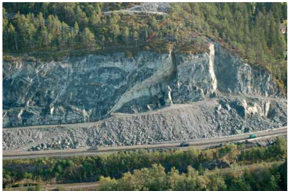
Som en gigantisk falløks henger Monolitten øverst i Løsberga – og venter... En støttefylling med stein og mindre steinblokker måtte anlegges nedenfor for å fange opp Monolitten, dersom den raste ut. Det gjorde den 3. november.
