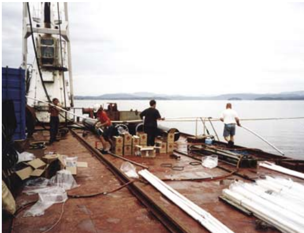
Nedføring av konturladninger i plastrør til dykker for lading av salve II.
