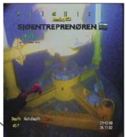
Montering av testbrønn 48 meters dybde
