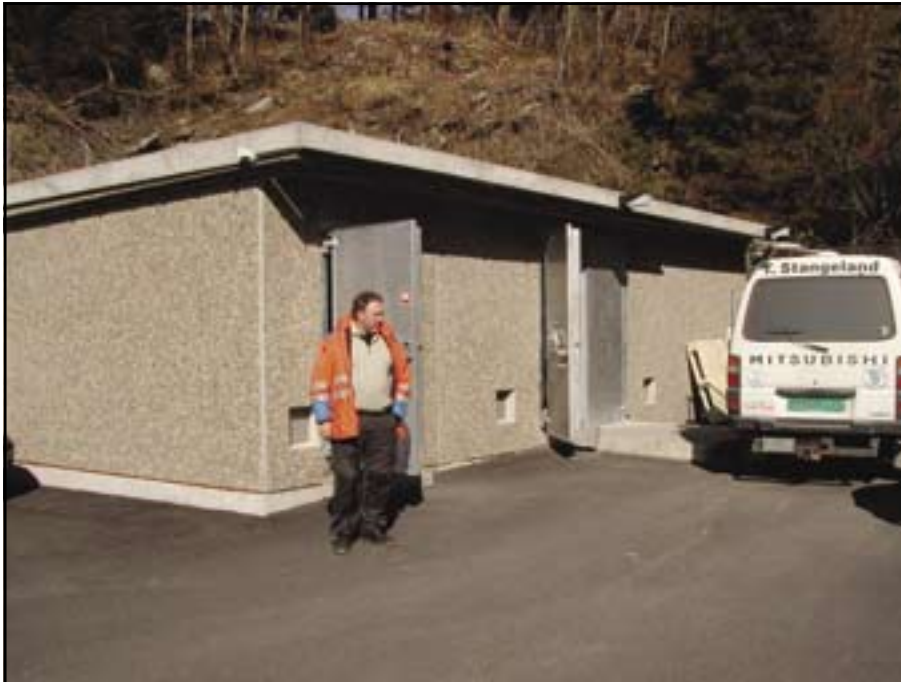
En stolt Hr. Nilsen viser mer enn gjerne frem sprengstofflageret
