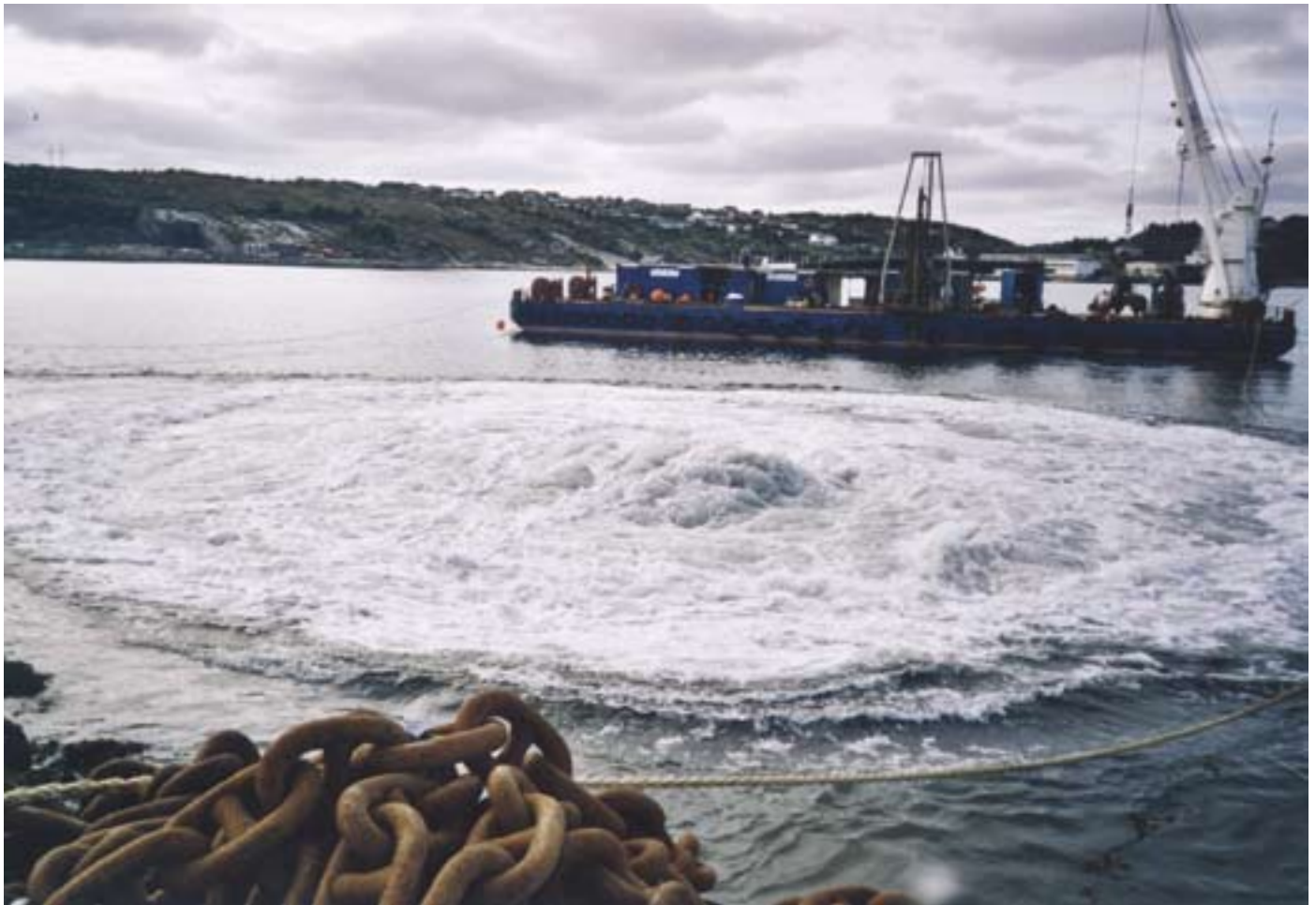
Sprengning av salve III, -22 til -38 m, 2000 m 3 gass til overflaten
