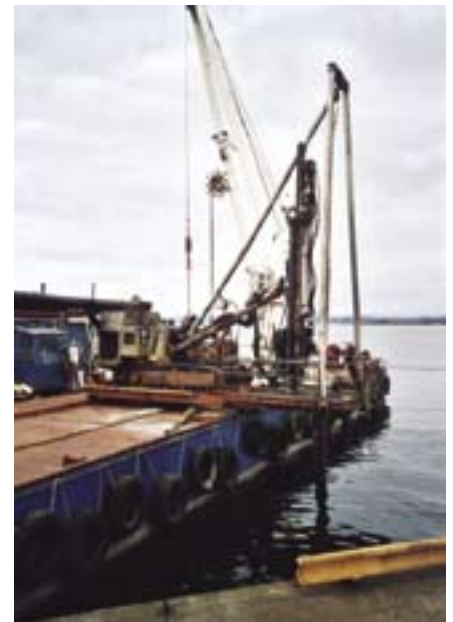
"Mjø II" i boringsposisjon utenfor dypvannskaien
