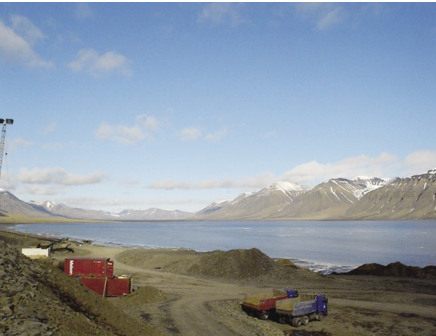
Utsikt fra riggområdet for tunnelen
