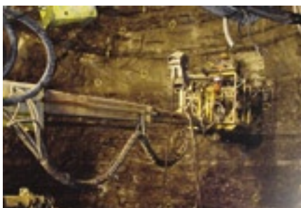
Tunnelrigg med ladekurv på stoff
