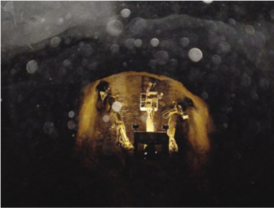
Tunnelriggen på stuff
