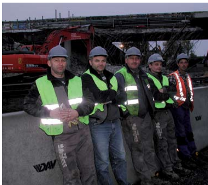
Fra venstre mod højre ses formand og sprængningsleder Erik Thyrring, Civ.ing. Poul Erik Hansen, maskinfører Niels Andersen, sprænger og maskinfører Jakob Lyng Andersen og maskinfører Stefan Sørensen fra nedrivningsfirmaet cmp Nedrivning A/S.
