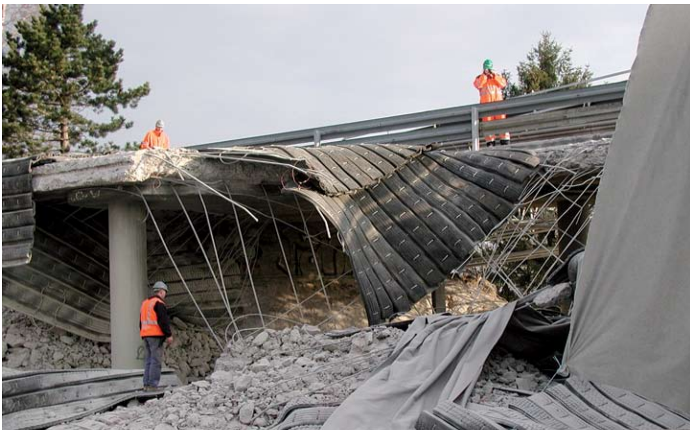
Effektivt og vellykket rivningsarbejde ved Motorring 3
