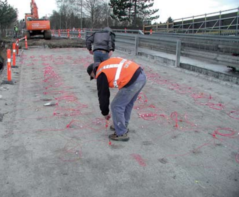
Sprængningerne udføres af Poul Erik Hansen og Erik Thyrring som sammen har mere end 30 års praktisk erfaring i betonsprængninger
