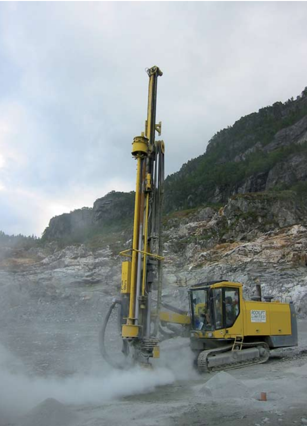
Boring gjennom sylte ved Norsk Stein på Jelsa Atlas Copco Roc L8 Senkborrigg
