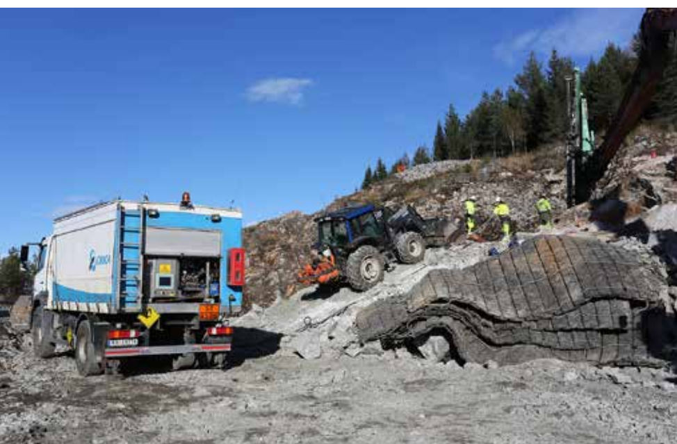
Orica forsyner hele E6-Dovrebanen-anlegget med emulsjonssprengstoff. Fire-fem salver om dagen er normalt.
