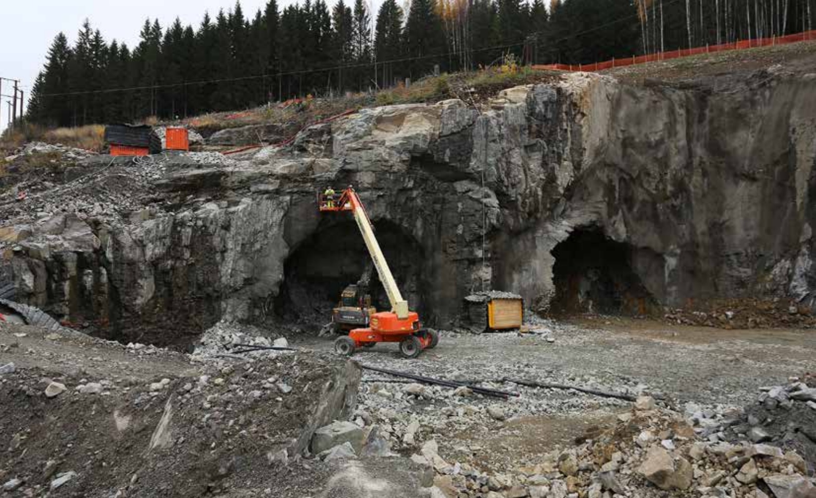
Påhogg til Morskogtunnelen i sør. Tunnelen drives av Veidekke Sverige.
