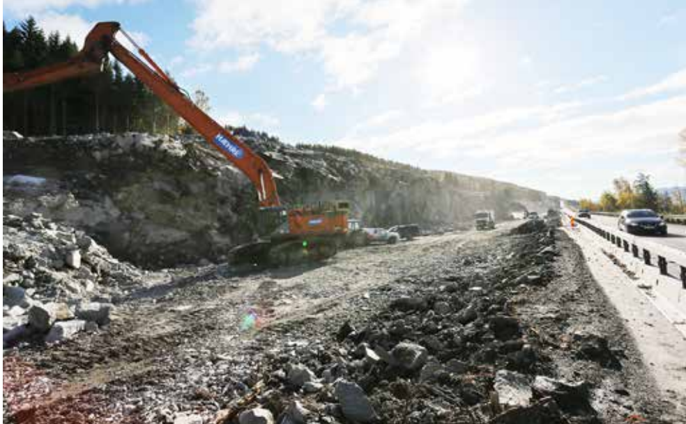
Anleggsmannskapene til Hæhre Entreprenør forsøker å skape skjæringer som står i stil med den vakre naturen rundt Mjøsa.
