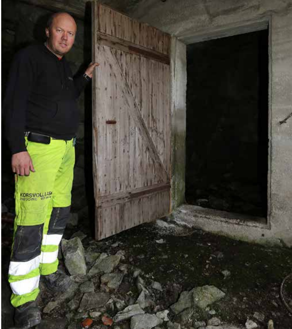
Da Statsbanene drev pukkverk på Joramo, ble sprengstoff og tennere oppbevart i dette sprengstofflageret.
