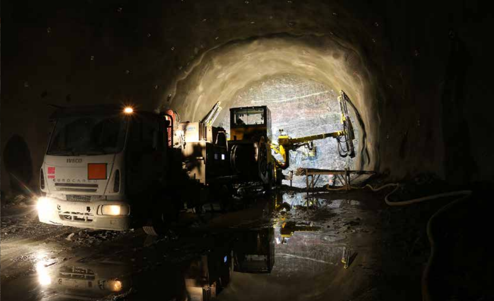
På stoffen i Ulvintunnelen. Oricas Handiloader™ deltar i både vei- og jernbanetunnelene langs Mjøsa. Ulvintunnelen blir den lengste tunnelen på Dovrebanen.
