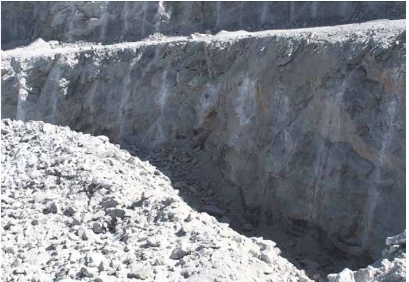
Røysen ble kastet godt frem fra veggene uten tegn på skadesoner eller for stor hullavstand
