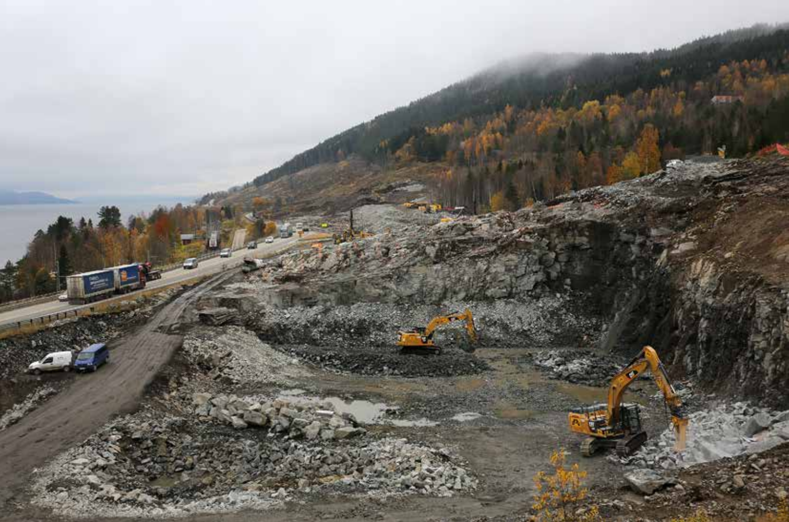
Anleggsområdet på Langset, like nord om Minnesund. Dette er søndre delstrekning, som drives av østerrikske Alpine Bau. Legg merke til jernbanelinja og toget som passerer.
