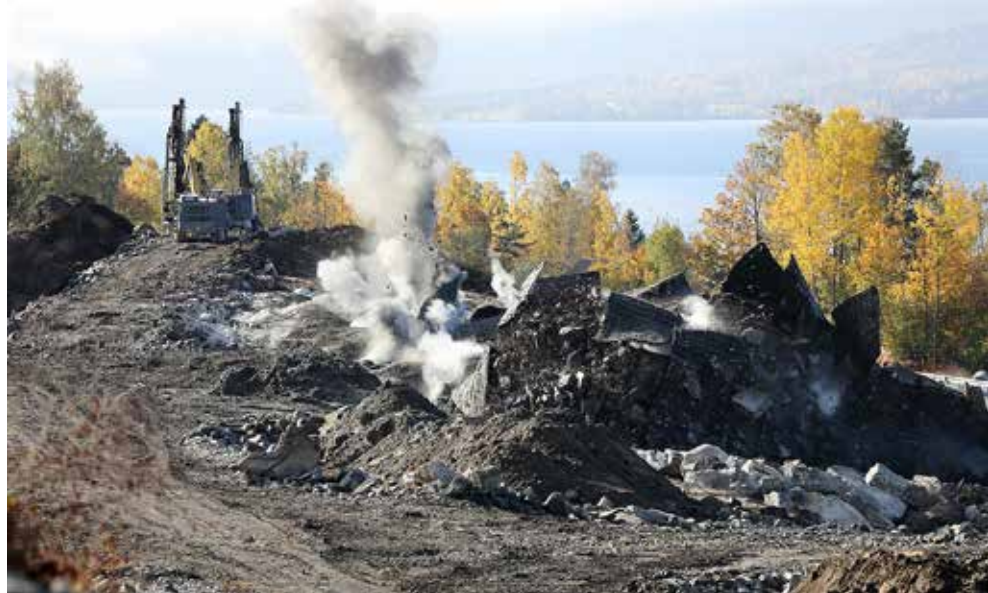
Tre tusen kubikk stein går i lufta på Espa. Hæhre Entreprenør står for utbyggingen av midtparsellen.
