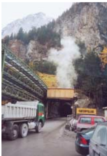
Påslaget i Mitholz (Fensterstollen). Krossade bergmassor fraktas ut med hjälp av transportband.
