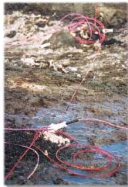
Nytt med Eclip är att den har en egentillverkad sprängkapsel med NPED-teknik, utan blyazid.
