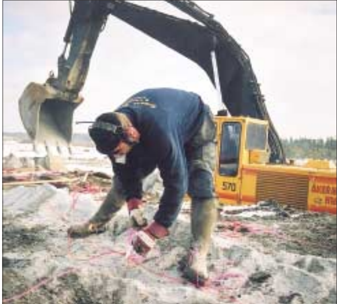
Kent Bryntesson använder Eclip vid sprängningar på Landvetter
