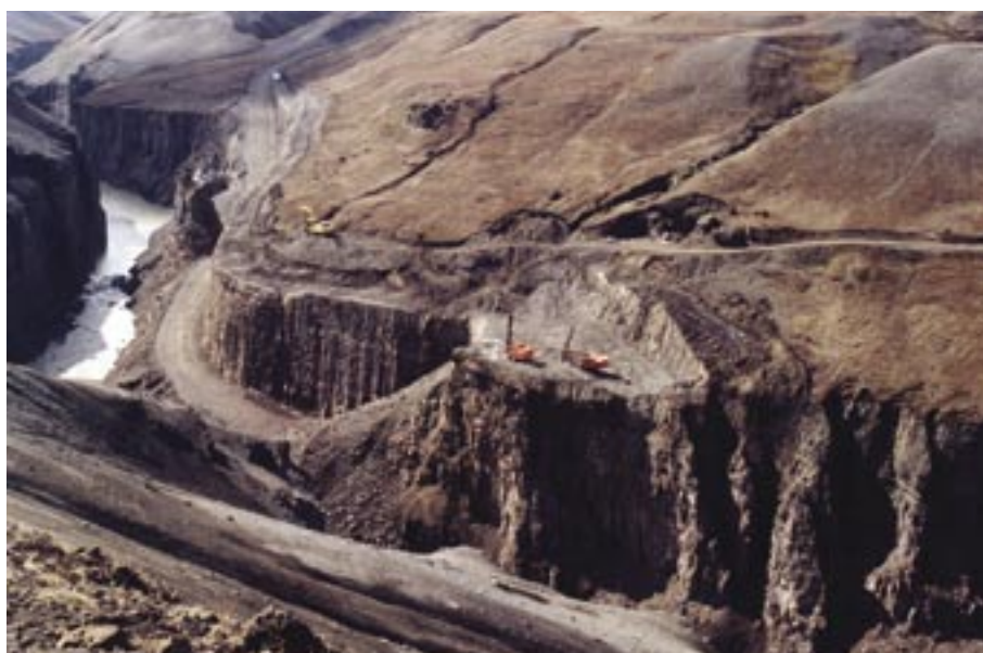
Sprängning av tillfartsvägen ner till dammfoten
