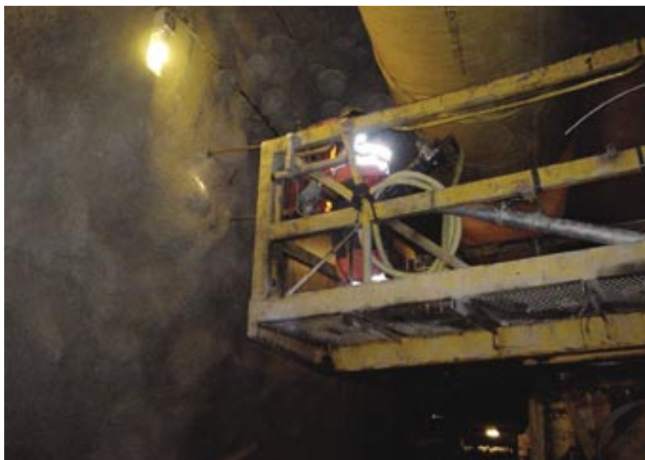
SSE-laddning från borrhiggens arbetskorg
