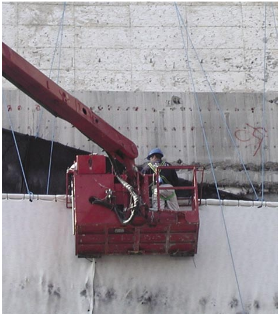
Omedelbart efter sprängning. Först sänks Dynamat sprängmattan ner och därefter sprängnäten. Sprängresultatet ses till höger.
