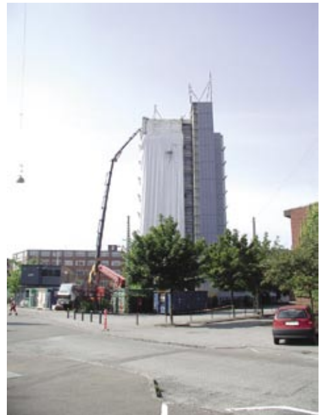
Allt klart för sprängning. Innerst hänger sprängnät och ytterst Dynamat sprängmatta för att fånga upp kast och förhindra att vinden tar tag i nedfallande betongstycken.
