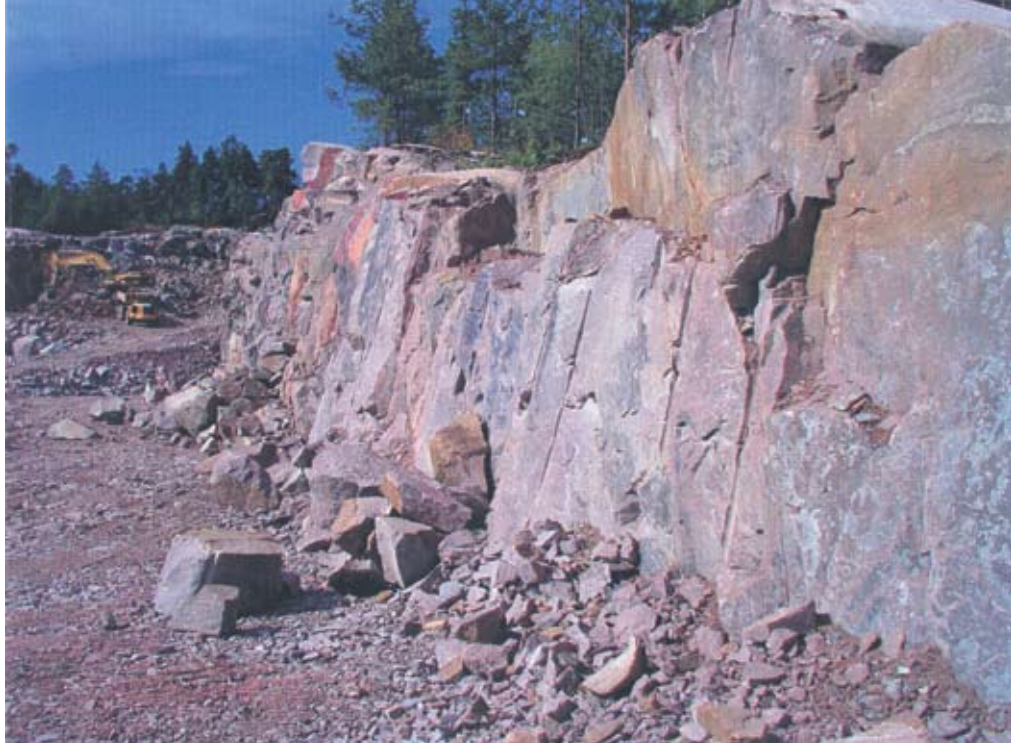
Figur 4. Förspäckt slänt vid Norrortsleden, Entreprenad 211:013.
