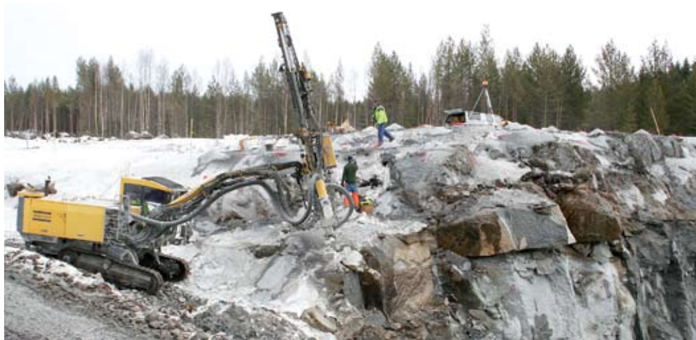
Mellan 250 000 och 300 000 kubikmeter berg ska tas loss i samband med terrasseringen på sträckan Ava-Nordmaling
