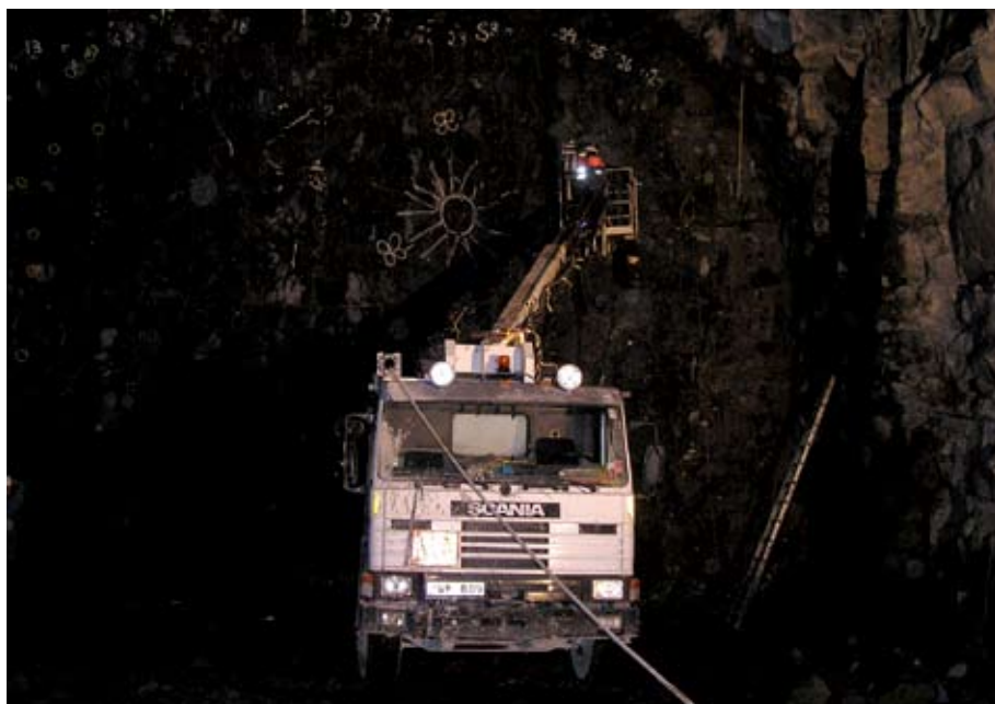
Laddning koppling med SSE 14B
